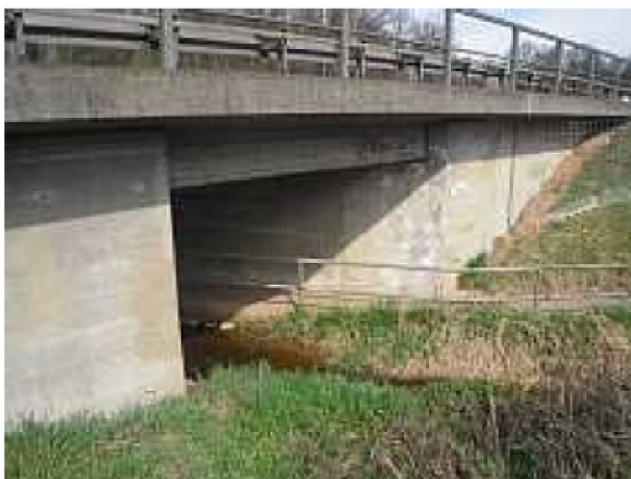
Abbildung 3: Durchlass A9 (Bauwerks-Nr F41)
