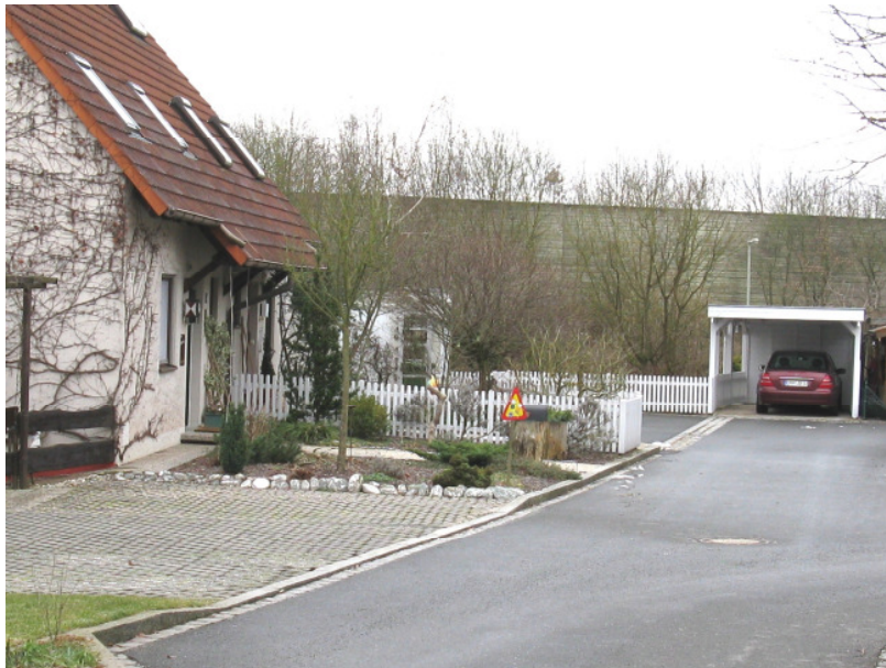
Lärmschutzwand im Süden von Bubenreuth
