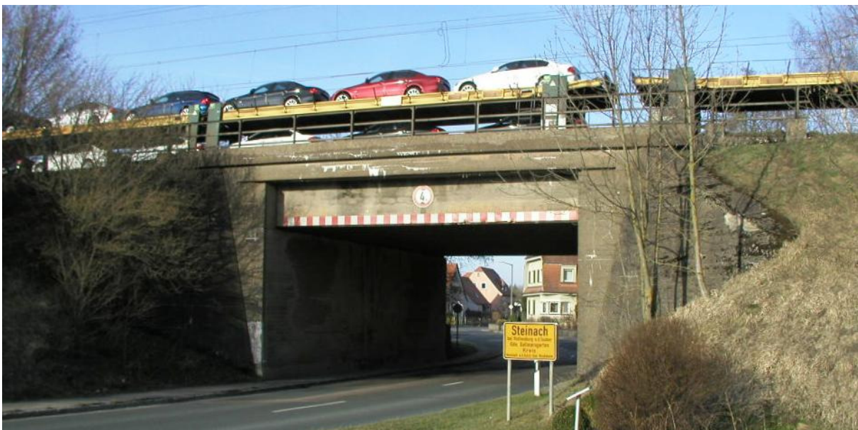
Bild 8: Ortsteil Steinach bei Rothenburg mit Bahnüberführung über die Bundesstraße 470 und an der Ortsdurchfahrt (Am Landturm) gelegenen Wohnhäusern (Blickrichtung Osten)
